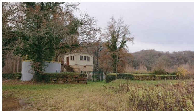
Station et puit de La Borgne
